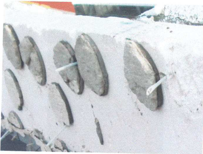
foto /31/ Detail kotev systému
