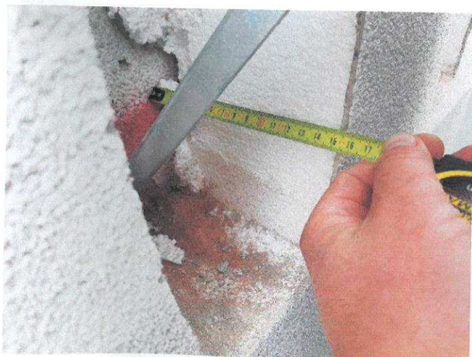
foto /11/ Sonda v místě kotvení nového komínu
