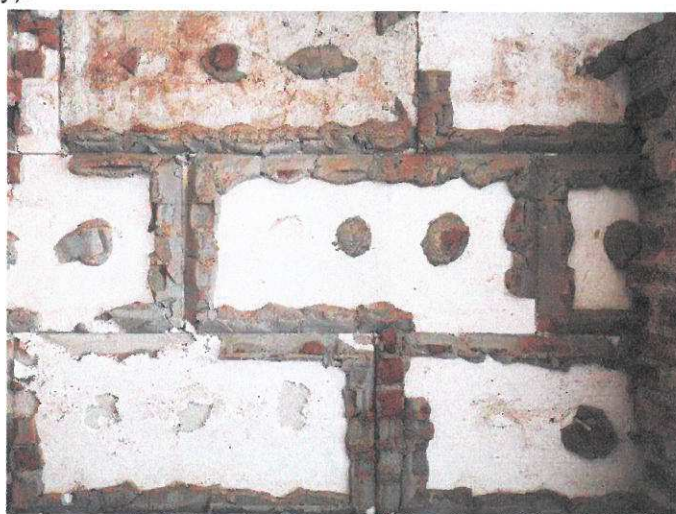
foto 1/2 Vnitřní líc ETICS po vybourání štítové stěny
