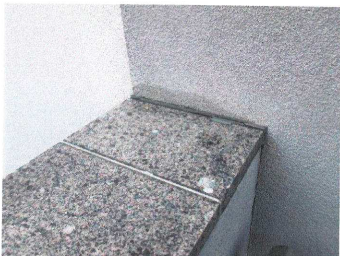
foto /27/ Detail ukončení zábradlí u severní fasády
