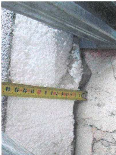
foto /15/ Lepidlo tl. 20 mm, EPS tl. 120 mm, základní vrstva tl. 1 mm
