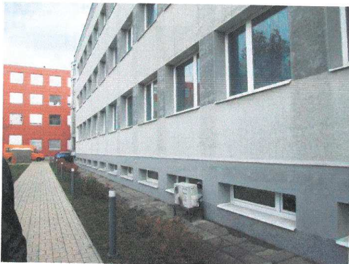
foto /19/ Západní fasáda (levá část z pohledu na fasádu)
