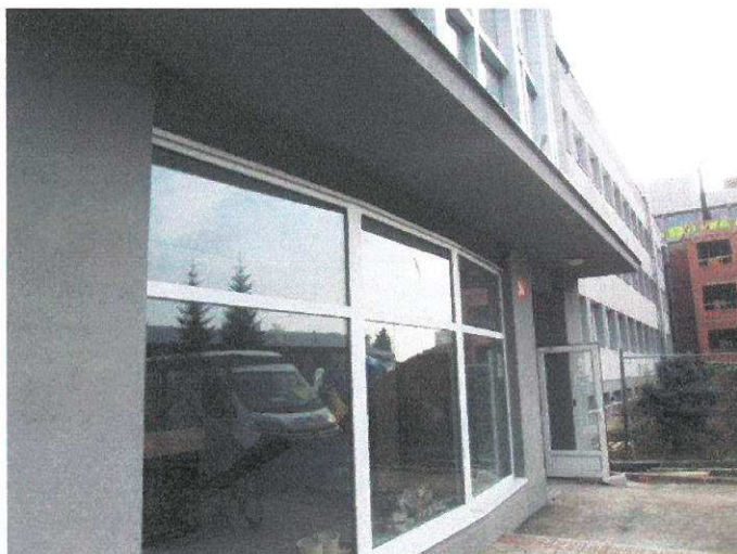
foto /17/ Zastřešení nad západním vstupem
