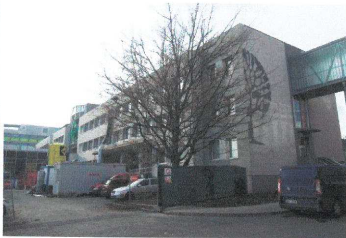
foto /4/ Pohled na objekt od severovýchodu
