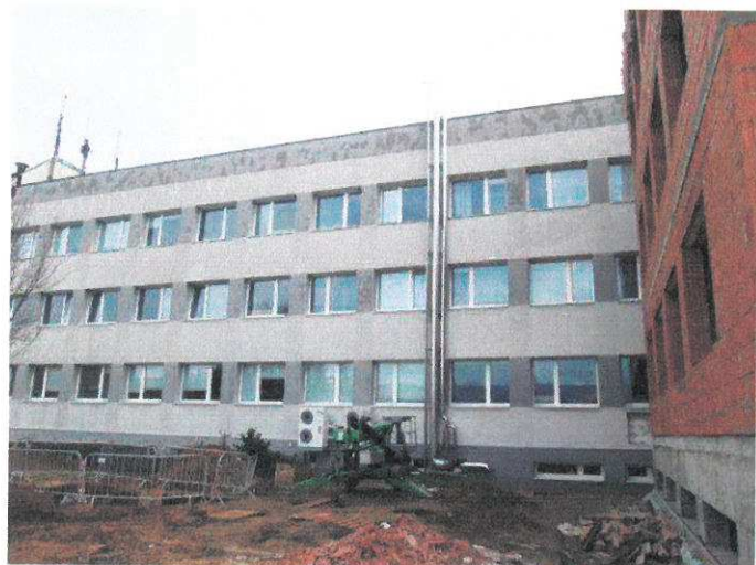
foto /5/ Západní fasáda (vpravo stavba přístavby)
