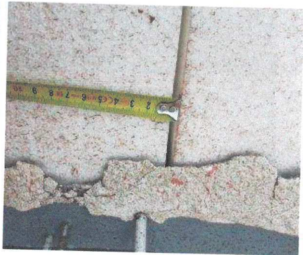
foto /32/ Mezera mezi deskami EPS 6 mm
