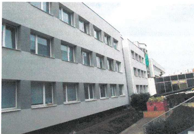
foto /3/ Východní fasáda objektu
