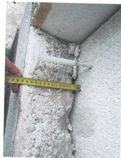
foto /36/ Základní vrstva v sondě 1 – tl. 1 mm
