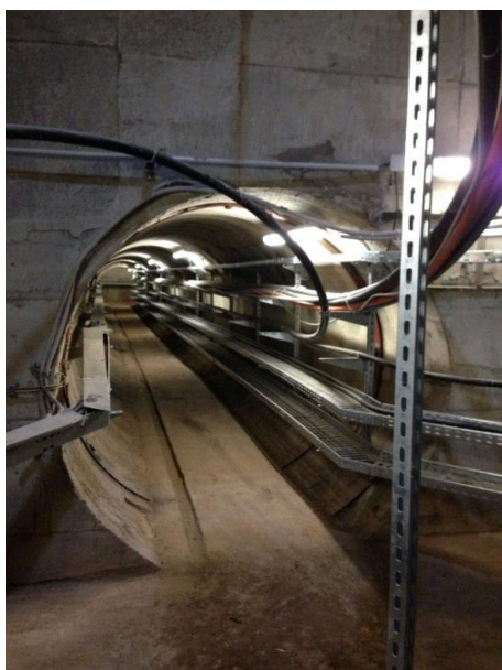
2. Šachta centrálního kolektoru se multikanály směřující na budovu Rektorátu
