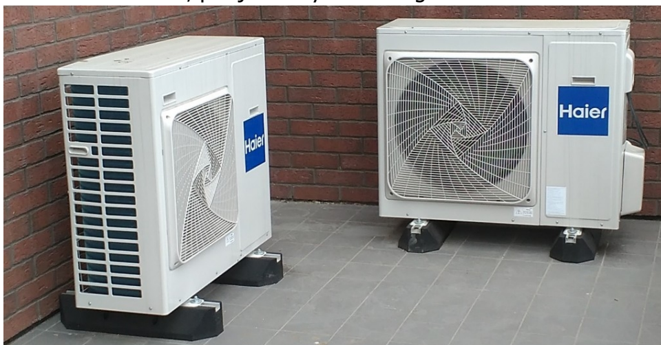
Obr. 3 – pryžové pražce pro uložení kondenzačních jednotek u paty objektu mezi osami H-05 a H-06, pro jednotky do 100 kg
