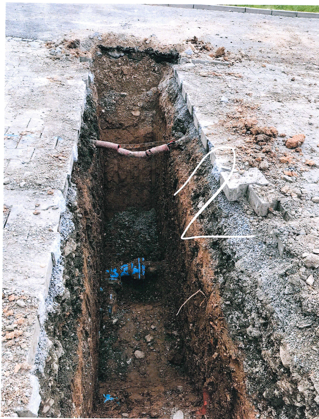
4) Přeložka vody - stav po odhalení
